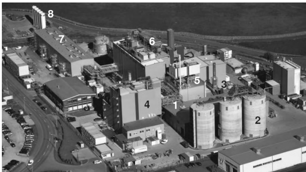
Obr. 4. Technologie výroby syntetické motorové nafty „Sundiesel“ společnosti Choren 18 ; 1 – úprava biomasy, 2 – sklad biomasy, 3 – sušení biomasy, 4 – Carbo-V proces, 5 – elektrárna, 6 – Fischer-Tropschova syntéza, 7 – čištění a zušlechťení, 8 – skladování Sundieslu
