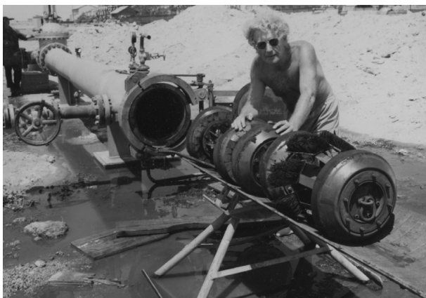
Obr. 1. Ing. Jaromír Škarka s „ježkem“ nebo „krtkem“ na čištění ropného potrubí
