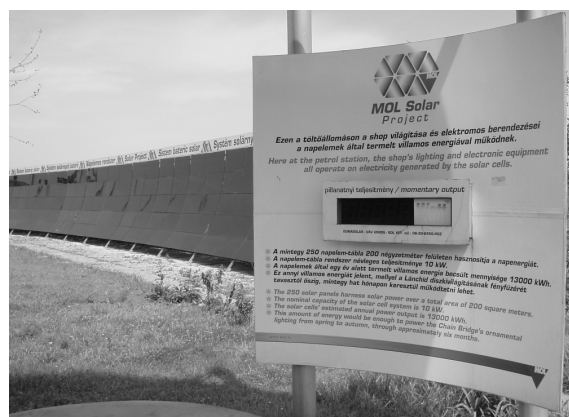
Obr. 2. 10 kW projekt solární elektrárny u benzinové stanice blízko Budapešti
