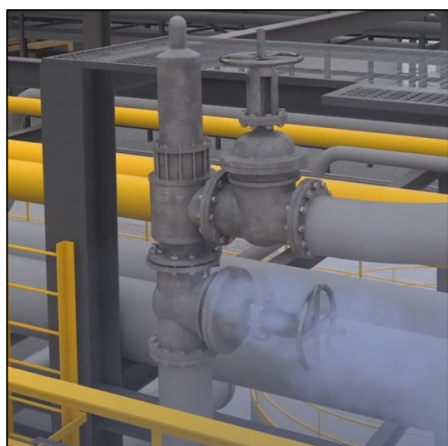
Obr. 4. Pojistný ventil propylenové kolony
