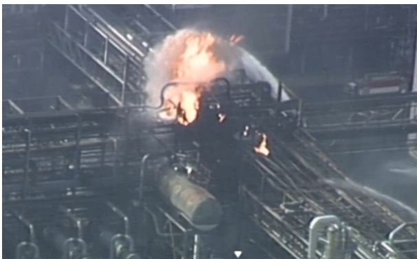
Obr. 6. Lokalizovaný požár v místě pojistných ventilů propylenové kolony
