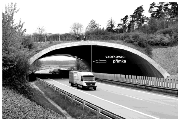
Obr. 3. Měřicí přímka v tunelu Zelený most
